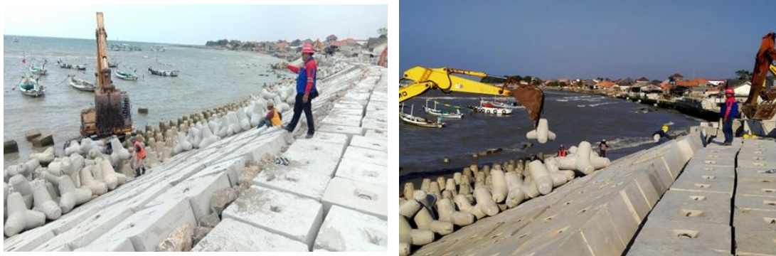
Gambar 7. Pemasangan Tetrapod 500 kg mutu K-500
