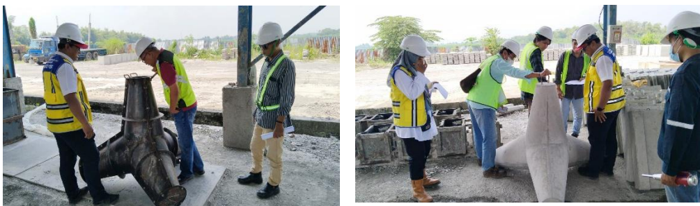
Gambar 6. Pengadaan Tetrapod 500 kg mutu K-500 (Sumber: Dokumentasi Pribadi, 2023)
