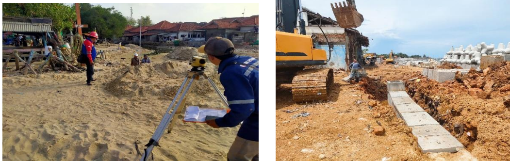
Gambar 8. Pengadaan dan Pemasangan U-Ditch (Sumber: Dokumentasi Pribadi, 2023)
