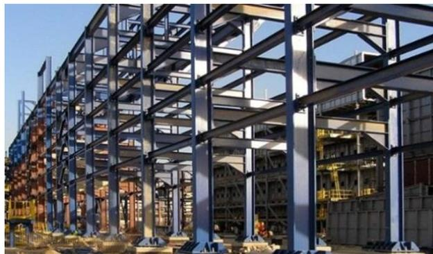
Gambar 24 : Struktur kolom baja H-beam
