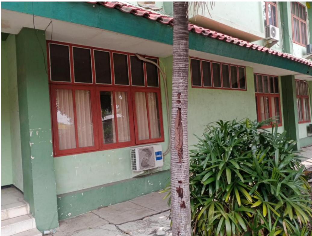
Gambar 3.(Foto Ikamto Budiman Th 2023) Detail Fasad Ruang Kuliah
