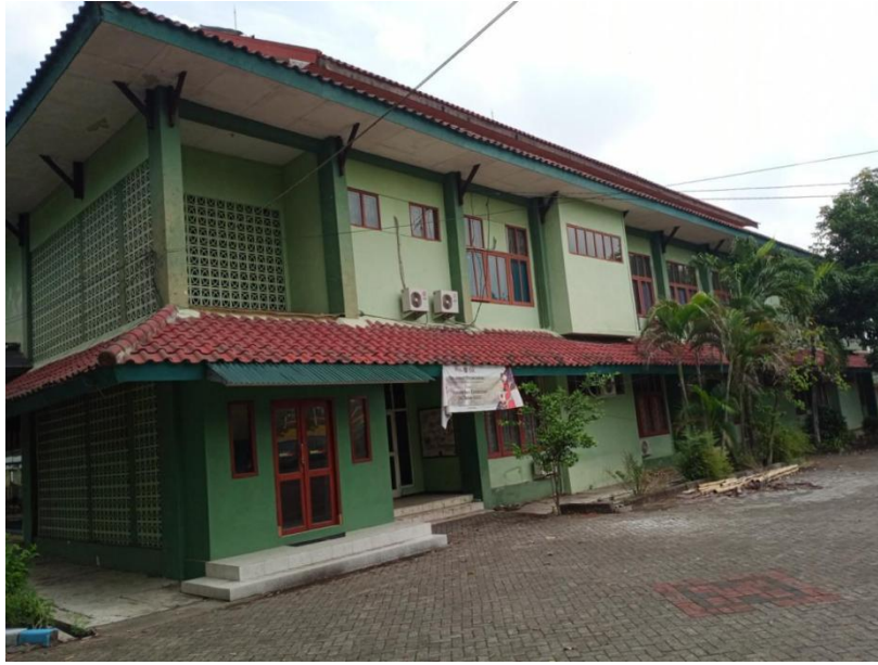
Gambar 2.(Foto Ikamto Budiman 2023) Fasad Selatan & Timur Gedung Fak Teknik Unmerbaya
